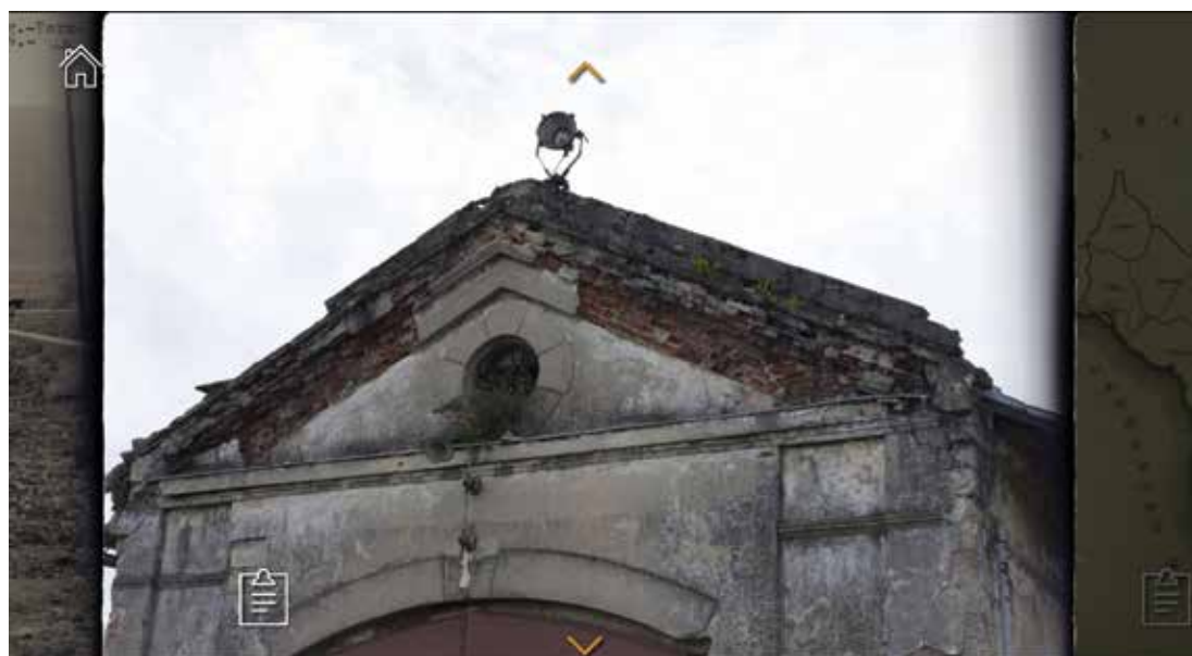
Slika 3. Lokomotivski depo (nekadašnja ložionica) u kolodvoru Plaški (detalj), lipanj 2014.
